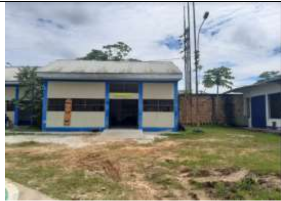
Foto del Almacenamiento de la Central Térmica
