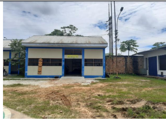
Foto del Almacenamiento de la Central Térmica
